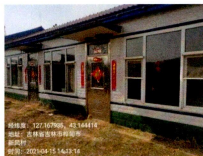
图 7 填报为土木/石木结构，与照片明显不符
