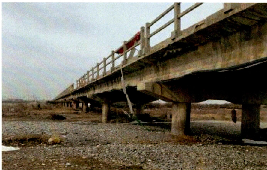
图 11 钢筋混凝土护栏现场照片
