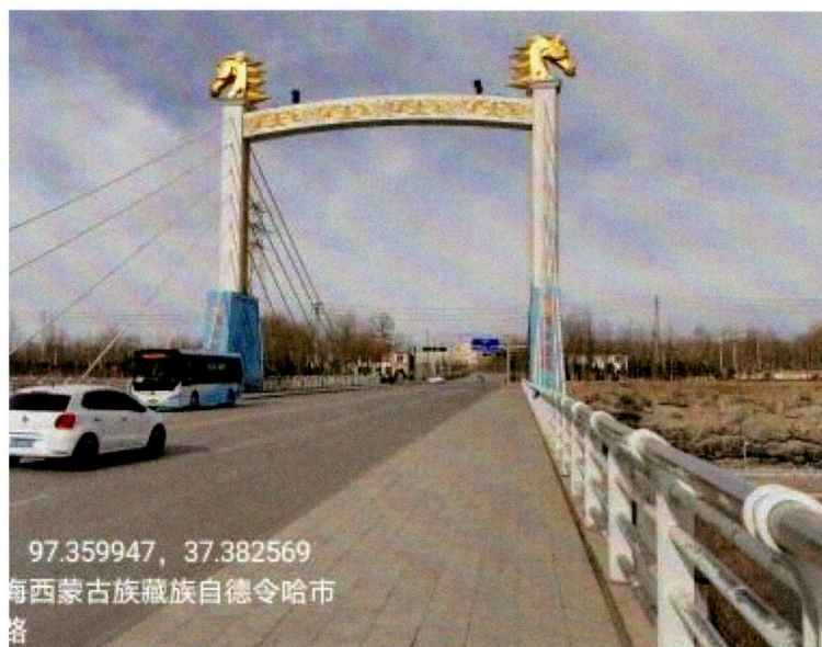
图 12 梁柱式护栏现场照片
